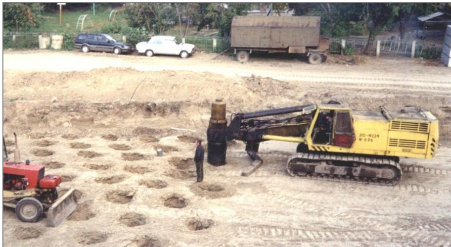
Рис. 3. Агрегат для глубинного трамбования грунта
